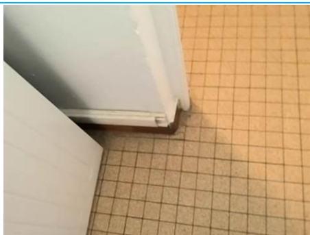
Matériaux : Z04 - Ensemble Bâtiment - Cuisine - Plinthe 15x10 - Colle de plinthe Prélèvement : P007 Description : colle de plinthe Localisation : Bat 2 / RDC - Logement Gauche / Cuisine - Plinthe Résultat : Présence d'amiante
