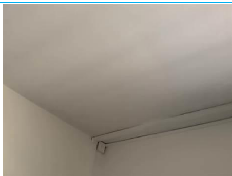
Matériaux : Z02 - Ensemble Bâtiment - Cuisine, Salle d'eau - Plafond - Peinture + enduit Prélèvement : P013 Description : enduit + peinture Localisation : Bat 2 / RDC - Logement Droite / Cuisine - Plafond Résultat : Présence d'amiante
