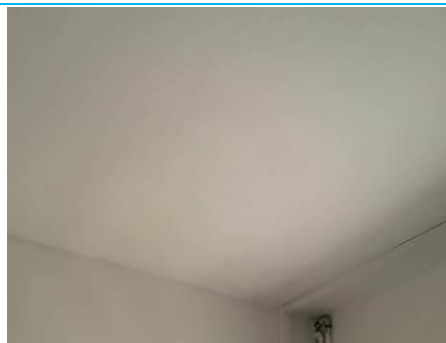
Matériaux : Z02 - Ensemble Bâtiment - Cuisine, Salle d'eau - Plafond - Peinture + enduit Prélèvement : P002 Description : enduit + peinture Localisation : Bat 2 / R+1 - Logement Gauche / Cuisine - Plafond Résultat : Présence d'amiante
