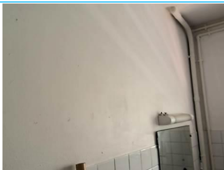
Matériaux : Z01 - Ensemble Bâtiment - Cuisine, Salle d'eau - Mur - Peinture + enduit Prélèvement : P009 Description : enduit + peinture Localisation : Bat 2 / RDC - Logement Gauche / Salle d'eau - Mur Résultat : Présence d'amiante
