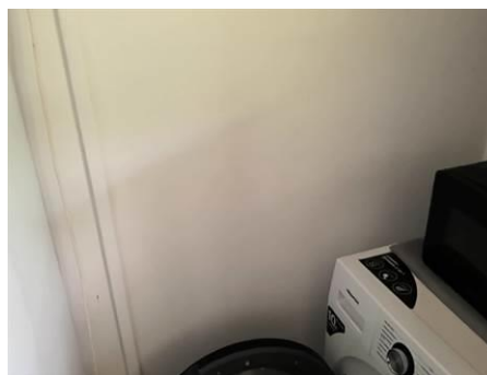
Matériaux : Z01 - Ensemble Bâtiment - Cuisine, Salle d'eau - Mur - Peinture + enduit Prélèvement : P012 Description : enduit + peinture Localisation : Bat 2 / RDC - Logement Droite / Cuisine - Mur Résultat : Présence d'amiante
