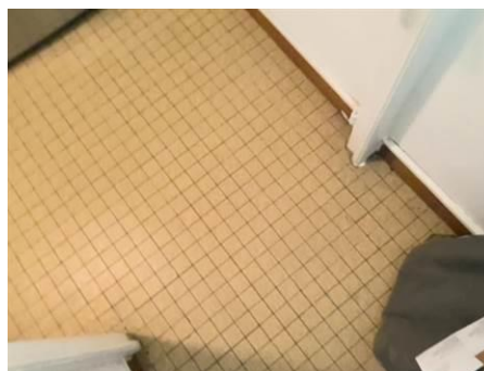
Matériaux : Z05 - Ensemble Bâtiment - Cuisine, Salle d'eau - Sol 5x5 - Colle de carreau Prélèvement : P008 Description : colle de carreau Localisation : Bat 2 / RDC - Logement Gauche / Cuisine - Sol Résultat : Absence d'amiante
