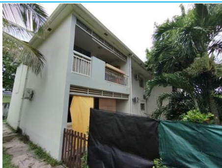
Matériaux : Z08 - Façades extérieures - Mur - enduit + peinture Prélèvement : P019 Description : enduit + peinture Localisation : Bat 2 - Façades Extérieures - Mur Résultat : Présence d'amiante
