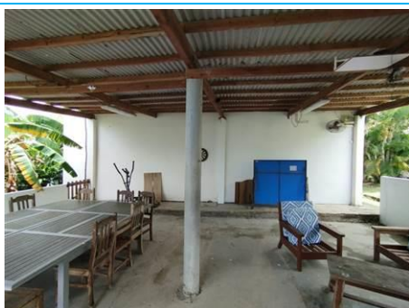
Matériaux : Z09 - Façades extérieures - Poteau - enduit + peinture Prélèvement : P015 Description : enduit + peinture Localisation : Bat 2 - Façades Extérieures - Poteau Résultat : Absence d'amiante
