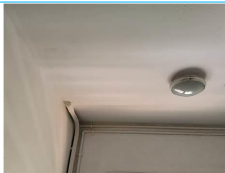
Matériaux : Z02 - Ensemble Bâtiment - Cuisine, Salle d'eau - Plafond - Peinture + enduit Prélèvement : P010 Description : enduit + peinture Localisation : Bat 2 / RDC - Logement Gauche / Salle d'eau - Plafond Résultat : Présence d'amiante
