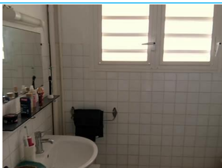
Matériaux : Z07 - Ensemble Bâtiment - Salle d'eau - Faïence 10x10 - Colle de faïence Prélèvement : P011 Description : colle de faïence Localisation : Bat 2 / RDC - Logement Gauche / Salle d'eau - Faïence Résultat : Présence d'amiante
