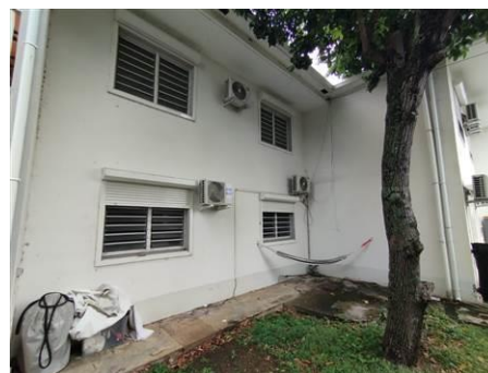
Matériaux : Z08 - Façades extérieures - Mur - enduit + peinture Prélèvement : P020 Description : enduit + peinture Localisation : Bat 2 - Façades Extérieures - Mur Résultat : Présence d'amiante
