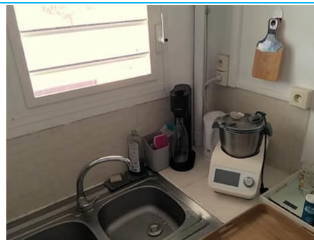
Matériaux : Z03 - Ensemble Bâtiment - Cuisine - Faïence 5x5 - Colle de faïence Prélèvement : P014 Description : Colle de faïence Localisation : Bat 2 / RDC - Logement Droite / Cuisine - Faïence Résultat : Présence d'amiante
